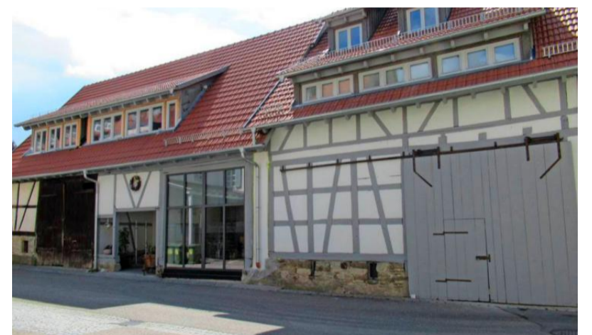
„Scheune sucht Freund“ heißt ein Projekt in Niedernhall. Familie Beck hat eine denkmalgeschützte Scheune zum Wohnhaus umbauen lassen. Architekten: Ulrich Schimmel und Stefanie Pawlenka, Öhringen.
