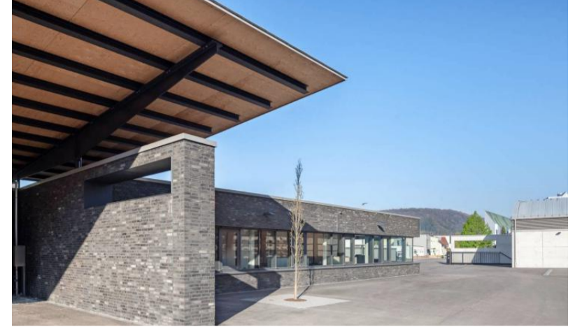
Der Bauhof der Stadt Künzelsau mit Umkleideräumen entstand nach Plänen der OHO Architekten PartGmbH, Stuttgart. Landschaftsarchitekt: Moehle & Partner, Stuttgart.
