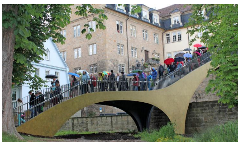
Der Ersatzneubau der Hofgartentreppe als kombinierte Treppen-Brücken-Konstruktion wurde nach Plänen von Ulrich Schimmel, Öhringen, zur Landesgartenschau 2016 gebaut. Auftraggeber: Stadt Öhringen.
